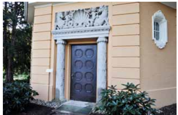
Abb. 8. Das Pumphaus von 1910, in dem sich die Pumpen für die Wasserleitungen und Regulierung des Seewassers befinden (vgl. Abb. 2). – Foto: F. Hoeck. Fig. 8. A Pump House from 1910, containing the pumps for the water pipes (cf. Fig. 2). – Photo: F. Hoeck.
